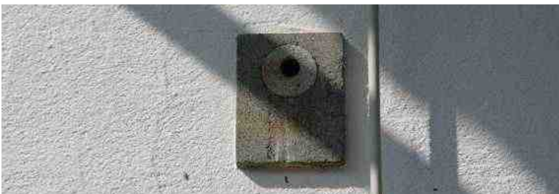
Beispiel 2 Niststein nach vorne versetzt und ohne Verputz.
