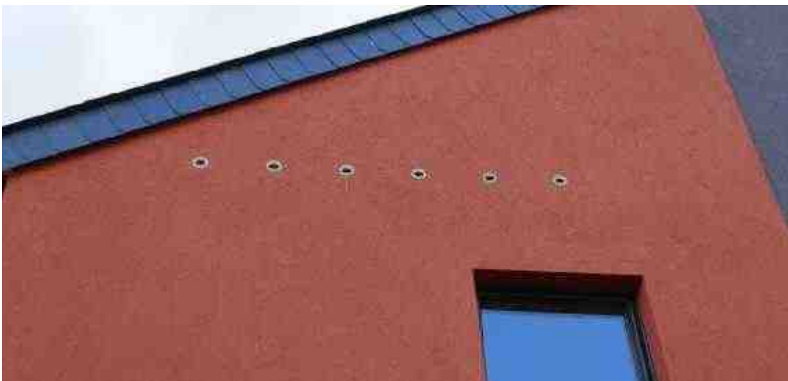
Beispiel 1 Einbau von Mauerseglerniststeinen
